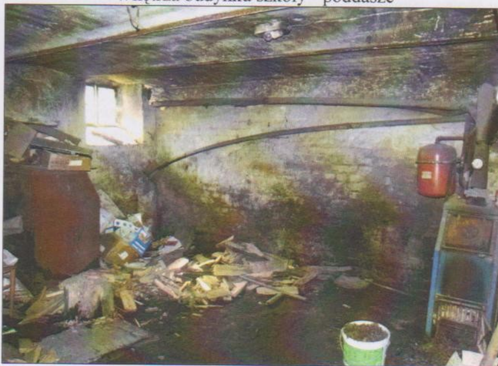
Wnętrza budynku szkoły - piwnice
