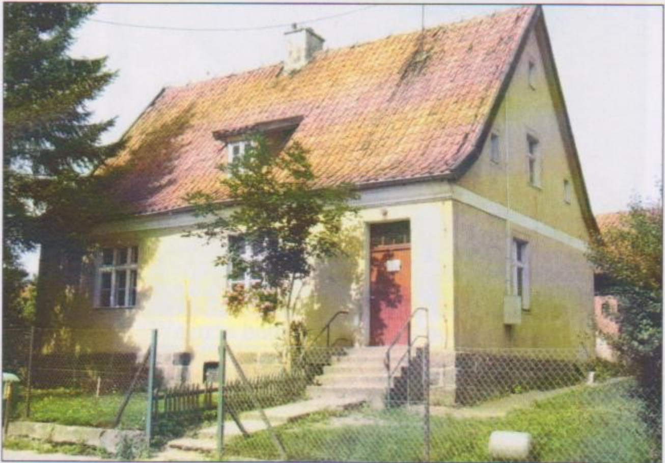
Widok elewacji budynku od strony drogi
